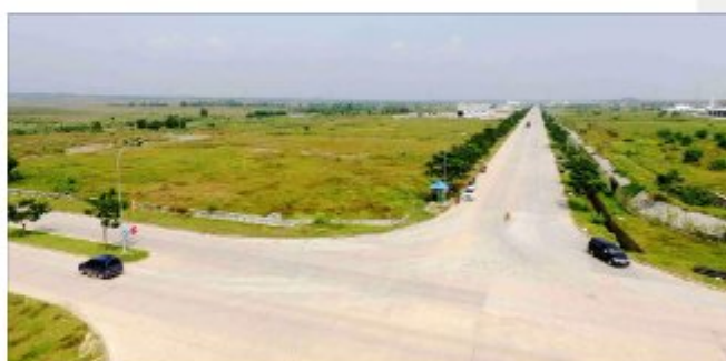
Proyek Jalan & Saluran Kawasan Deltamas
