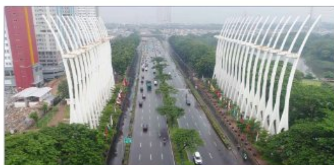
Proyek Pelebaran Ruas Tol Kemayoran
