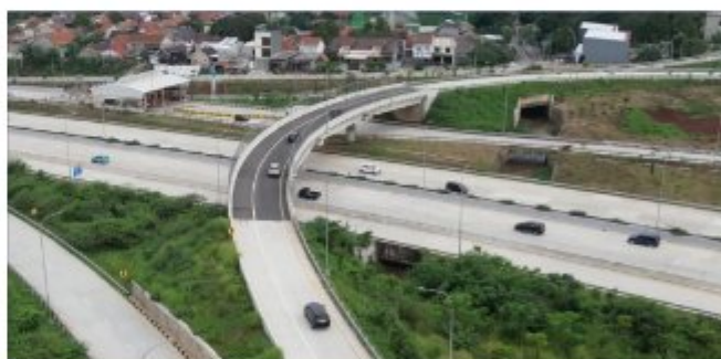
Proyek Jembatan Krukut (Ramp 8) Seksi 1 Selatan
