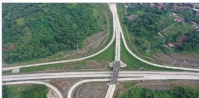
Proyek Jalan Tol Cisumdawu Seksi 3
