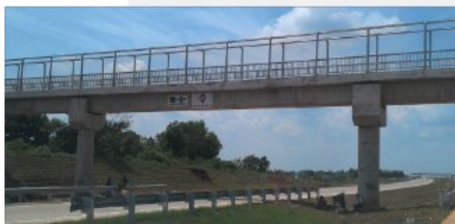
Proyek Jembatan Tol Cipali
