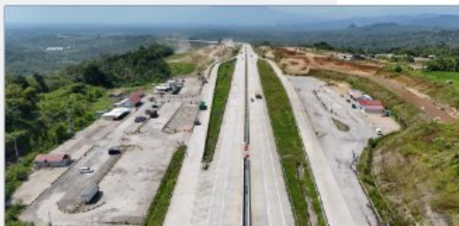
Pembangunan Rest Area Jalan Tol Cisumdawu
