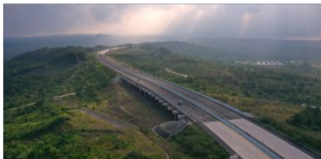
Proyek Jalan Tol Cisumdawu Seksi 5b
