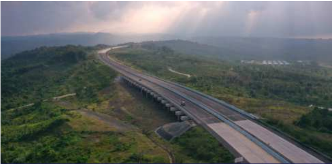
Proyek Jalan Tol Cisumdawu Seksi 5b
