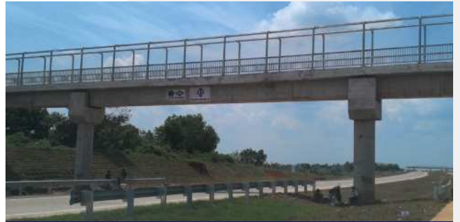
Proyek Jembatan Tol Cipali
