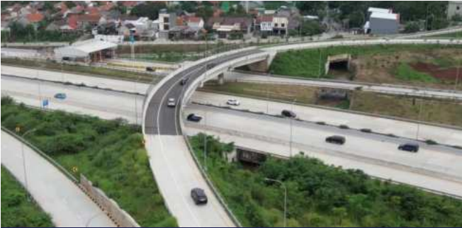
Proyek Jembatan Krukut (Ramp 8) Seksi 1 Selatan
