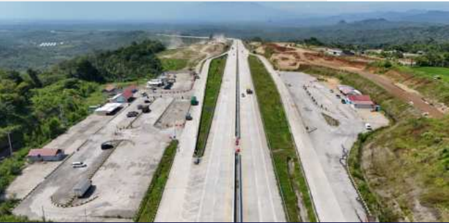
Pembangunan Rest Area Jalan Tol Cisumdawu
