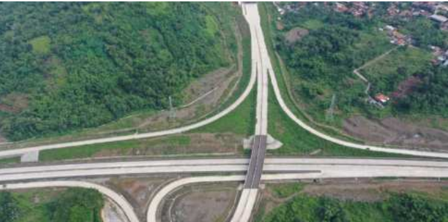
Proyek Jalan Tol Cisumdawu Seksi 3
