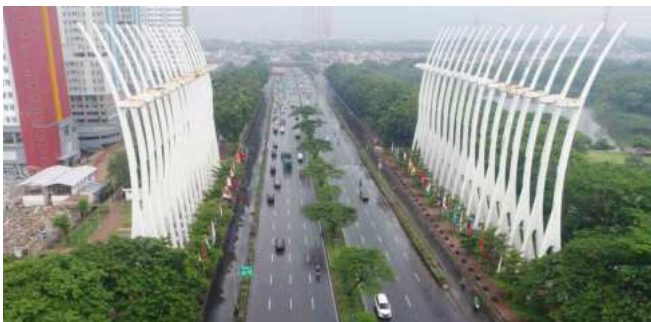
Proyek Pelebaran Ruas Tol Kemayoran
