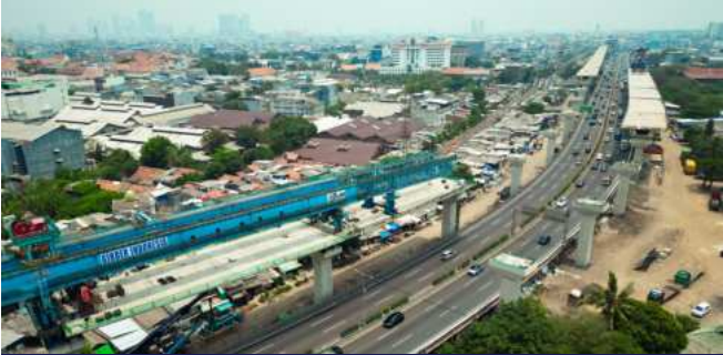
Jalan Tol Ancol Timur – Pluit (Elevated)
